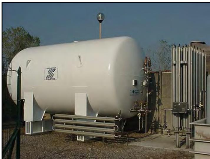
Vaporizzatore: scambiatore atmosferico a tubi alettati in grado di garantire la corretta e sufficiente vaporizzazione dell'azoto liquido.
