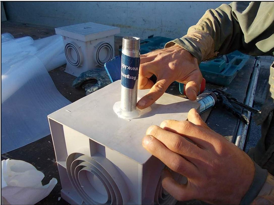
Figura 2-2 – Realizzazione pozzetto di monitoraggio sub-slab
